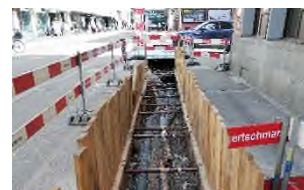
Vorbereitung für Seewasser-Wärmeverbund
