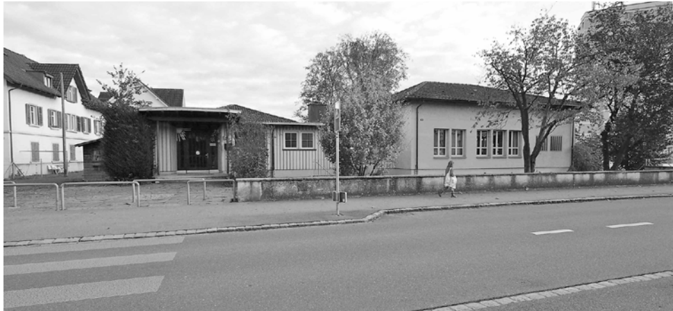
Jetziger Kindergarten: Ansicht von der Salmsacherstrasse
