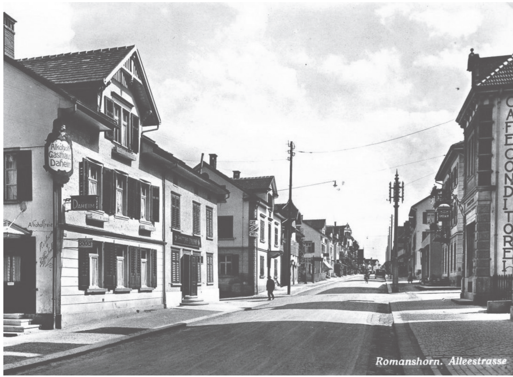
Wohn und Geschäftshäuser entlang der Alleestrasse
