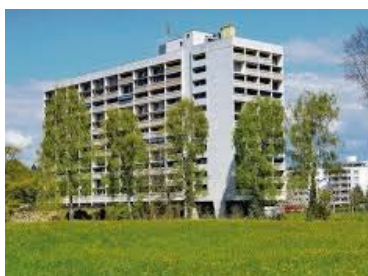
Arbon: Hochhaus von Jakob Eschenmoser Architekt, eine Unité d'habitation in Anlehnung an Le Corbusier.
