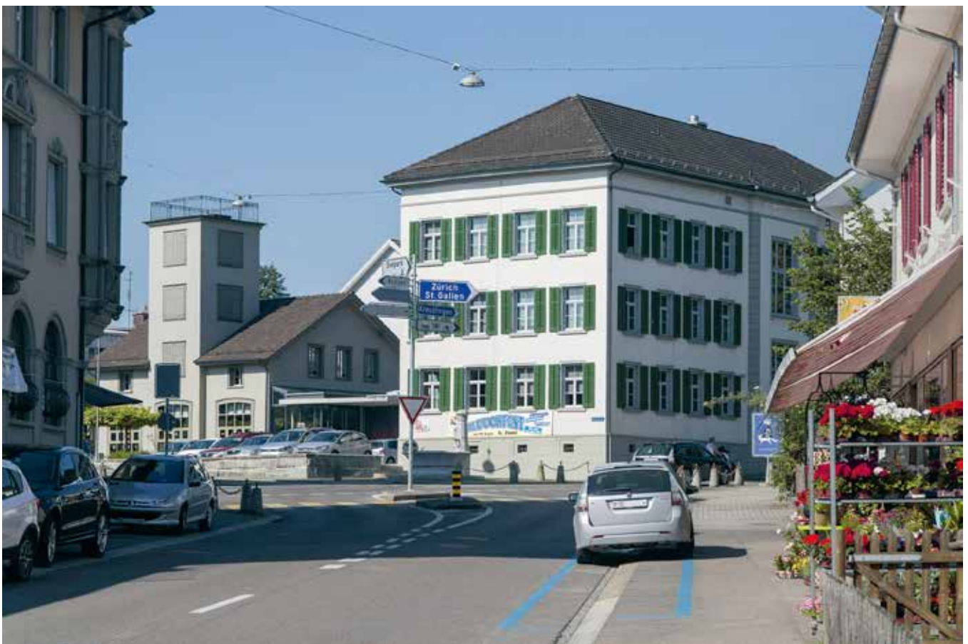
Bauhistorisch wertvolle Bauten an der Kreuzung Hafen-/Bahnhof-/Salmsacherstrasse.
