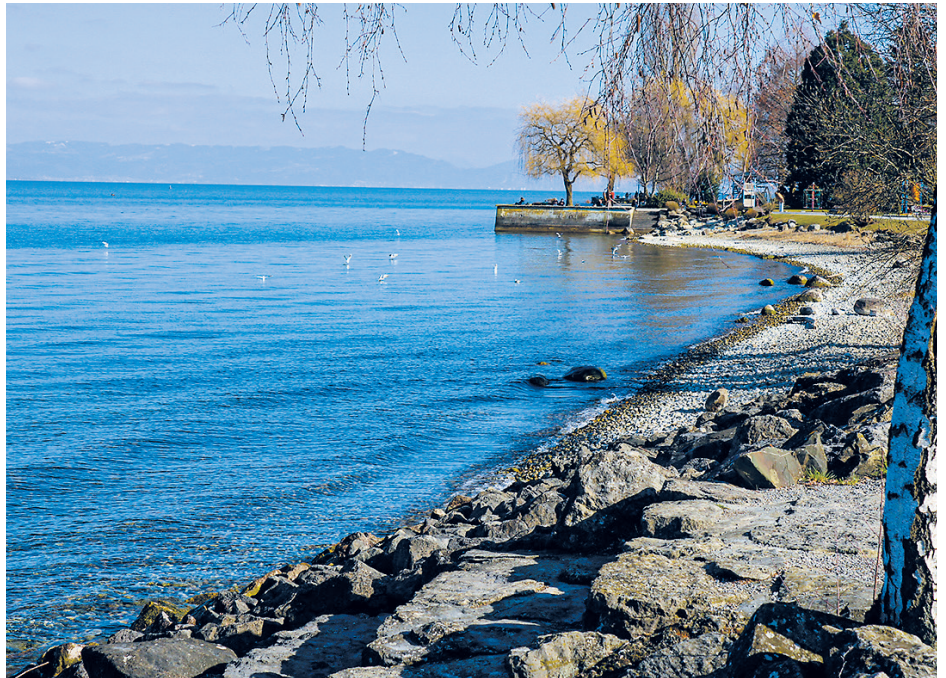
Seeufer soll saniert werden.
