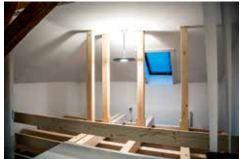
Balken und Streben zur besseren Ableitung der Dachlasten im Sitzungszimmer 3. OG
