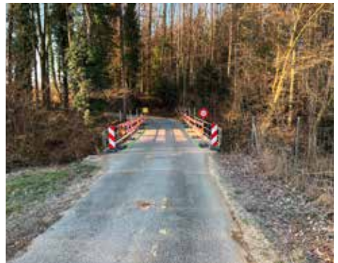
Brücke Aach, Straubenhaus
