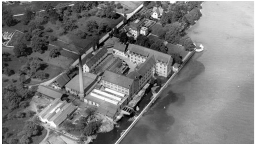
Abb. 26 Luftbild des Hydrel-Areals im Jahr 1947 mit Ufermauer, hydrel.ch
