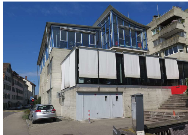
Fehlende EG Nutzung
