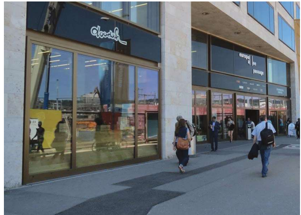
Europallee Baufeld A Zürich, Max Dudler
