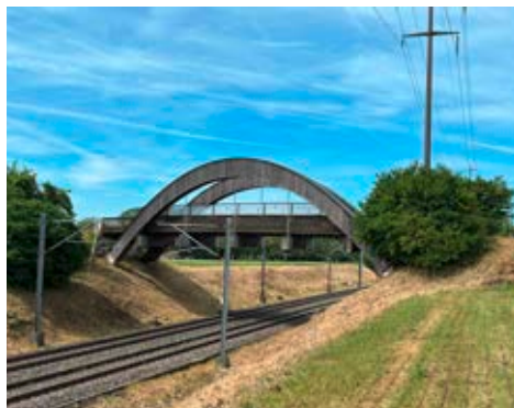
Mängelbehebung Holzbrücke Aach
