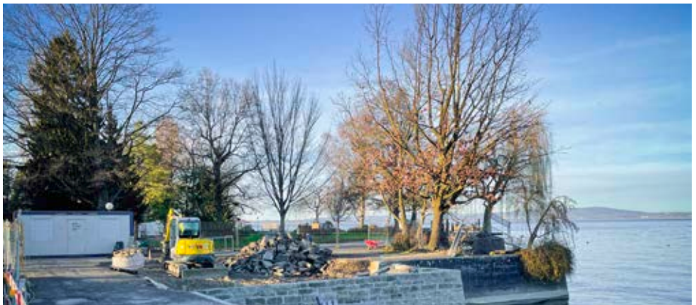
Seeufersanierung: Instandsetzung Felskanzel Inseli
